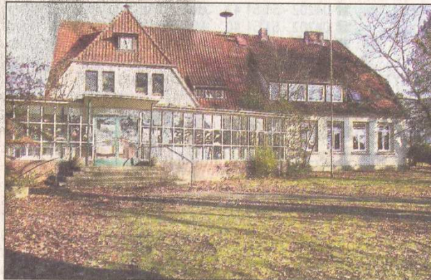
Hier vor dem gläsernen Wandelgang soll die neue Pausenhalle der Ueser Grundschule entstehen. Dass unter dem Rasen ein alter Löschteichbrunnen der Feuerwehr liegt und daher nicht so einfach drauflosgebaut werden kann, wurde erst kürzlich festgestellt.
