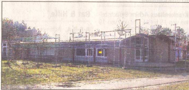
Es wird schon fleißig gearbeitet an der Wiederherstellung des verbrannten Trakts der Grundschule Bierden. Die Instandsetzung wird jedoch viel länger dauern als erwartet.
