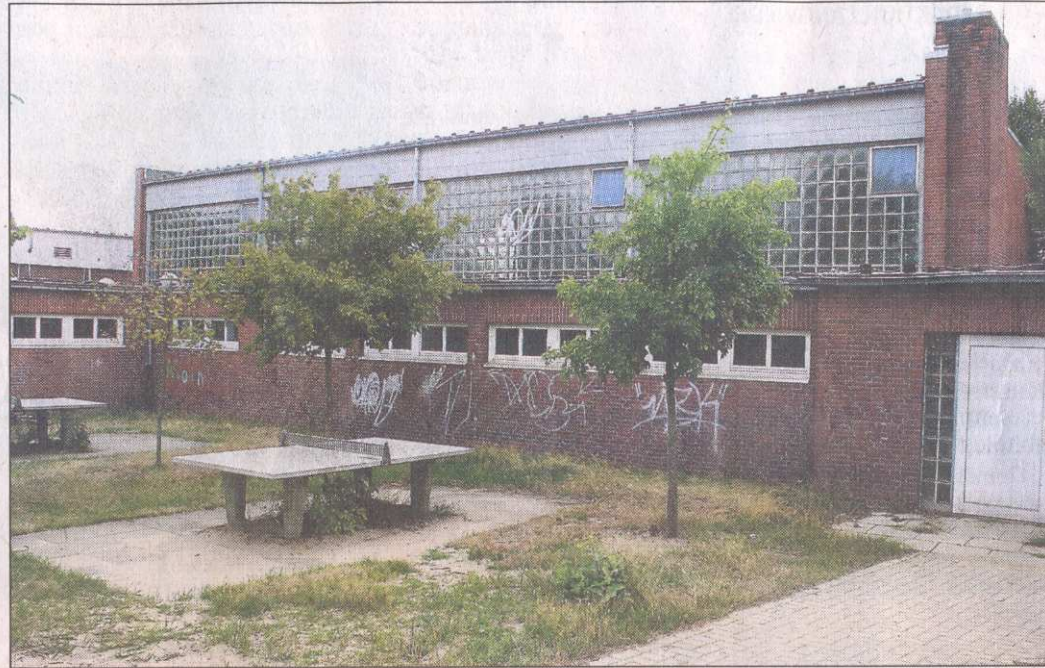
Die alte Turnhalle in Uesen soll saniert werden.
