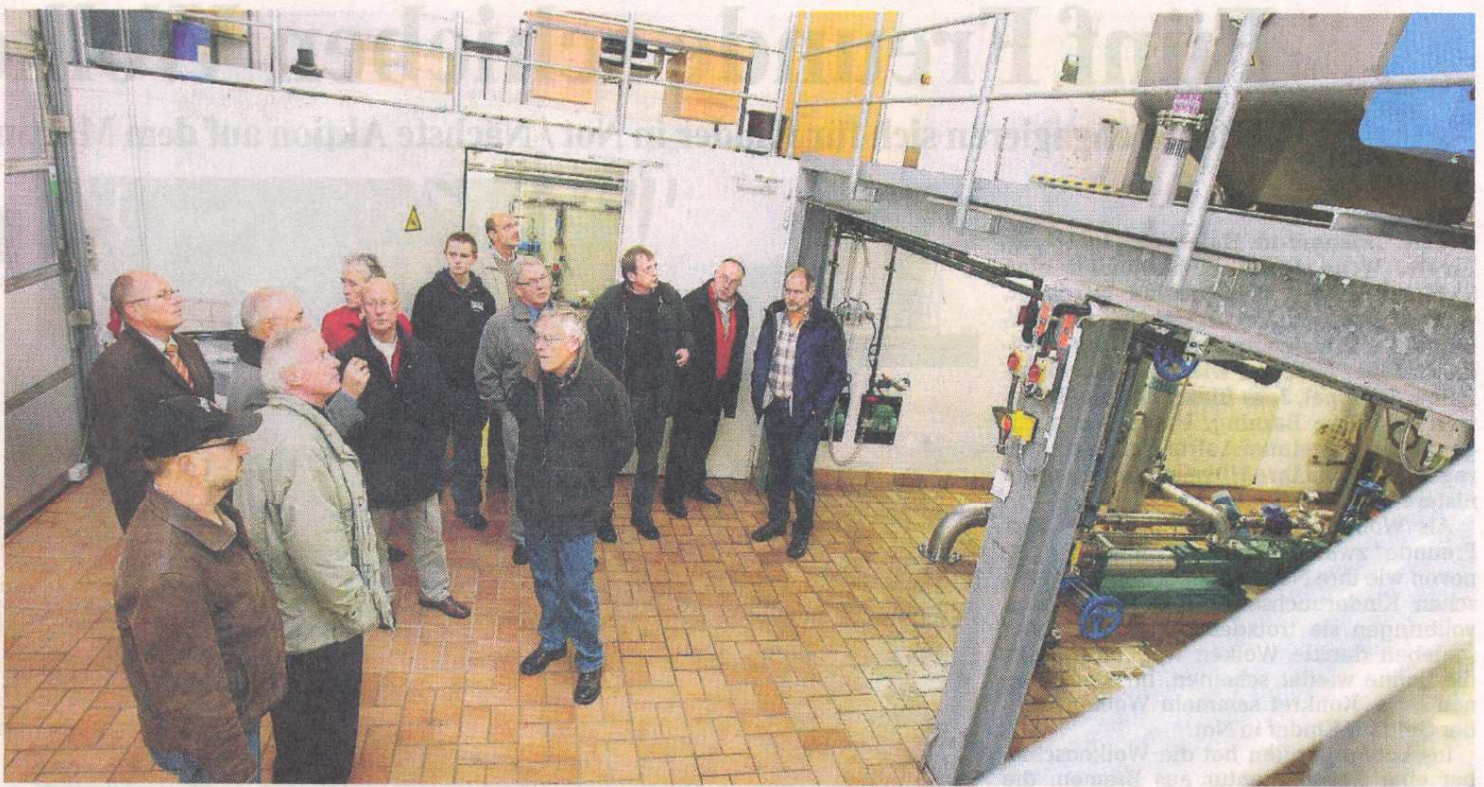
Die Mitglieder des Werksausschusses auf Stippvisite: Das Gremium inspizierte jetzt das aufgestockte Betriebsgebäude und die neue Technik des Achimer Klärwerks. Insgesamt sind 1,4 Millionen Euro in zusätzliche Räume und Apparaturen investiert worden. FOTO: CHRISTIAN BUTT
