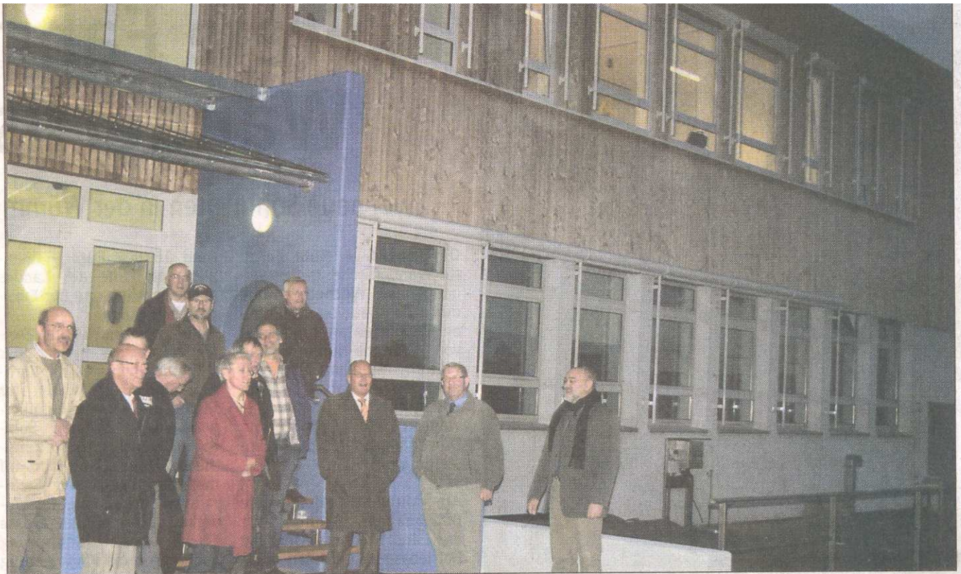
Die Kläranlage verfügt nun über ein modernes Betriebsgebäude, befand der Werksausschuss Abwasserbeseitigung. Fotos: Mix
