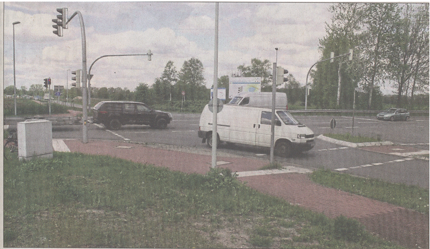
Schon heute belastet: die Kreuzung Uesener Feldstraße, Im Finigen und Max-Naumann-Straße (hinten) mit dem freien Areal. • Foto: Mix
