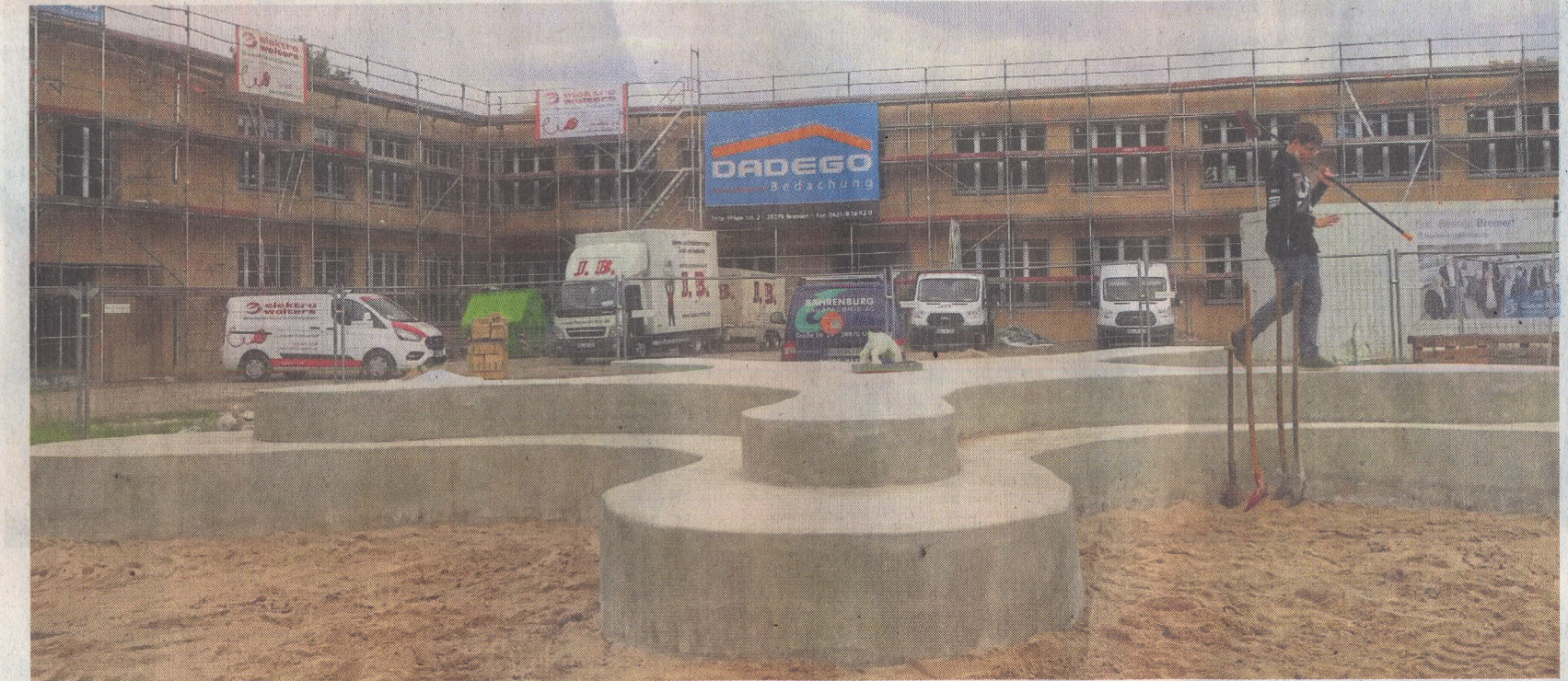
Die Bauarbeiten fürs IGS-Lernhaus an der Waldenburger Straße schreiten weiter voran. Im Vordergrund nimmt ein Campus-Jugendprojekt des Vereins Sozialpädagogischen Familien- und Lebenshilfe Achim (Sofa) Formen an. Es entsteht hier eine „Insel“. Mehr dazu demnächst.
