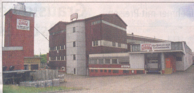
Die stillgelegte Brotfabrik zwischen Eisenbahnbrücke und Aldi an der Embser Landstraße. Die Zufahrt zum Lieken-Gebiet könnte problemlos auch hier verlaufen, allerdings wäre das Areal dann für die Stadt nicht so effektiv zu nutzen. ■ Foto: Brodt
