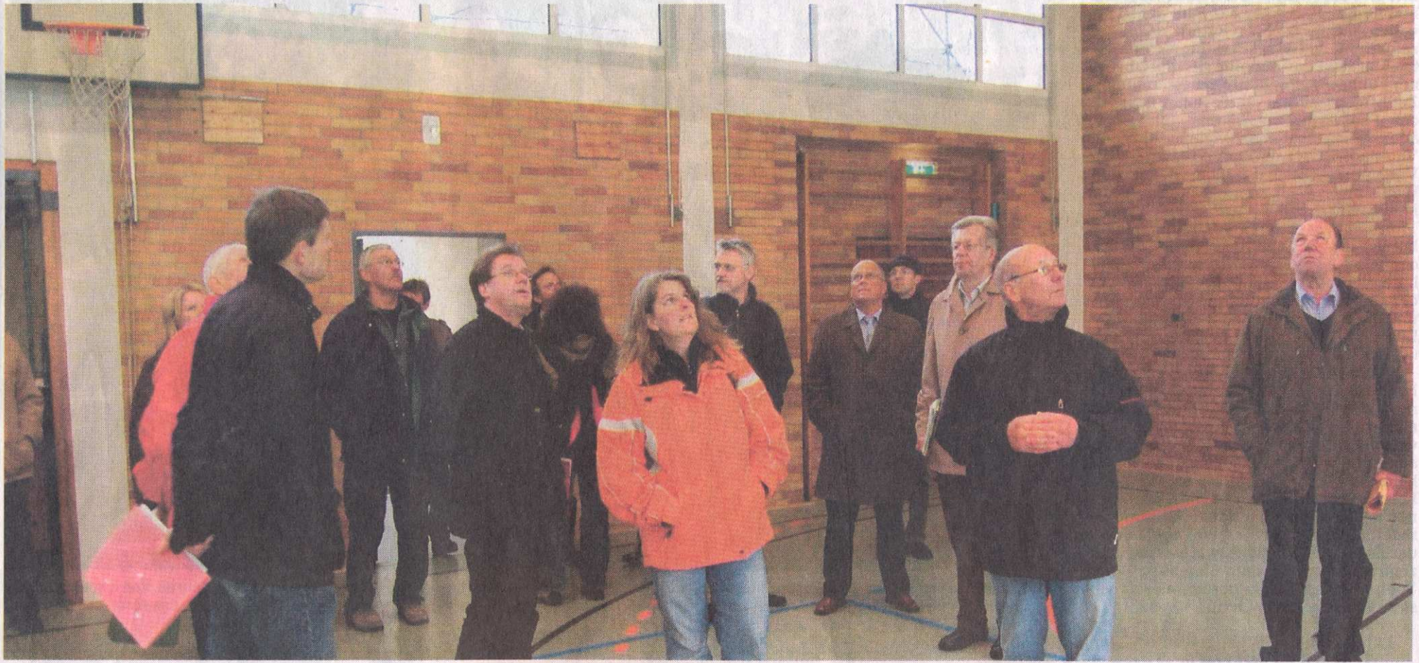
Alle Blicke nach oben: Der Ortsausschuss Bierden auf der Suche nach schimmeligem Ecken in der Schulturnhalle. Ein Teil der Hallensanierung ist inzwischen erledigt, doch bis die Baumaßnahme endgültig abgeschlossen sein wird, vergehen noch Jahre. Was im Kreis der Eltern weiterhin für Unruhe sorgt. FOTO: RALF MICHEL
