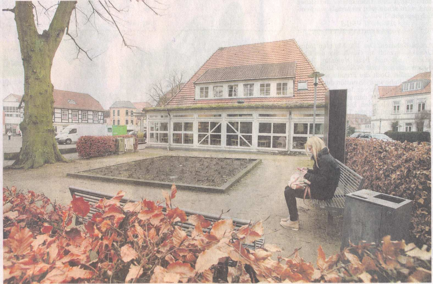
Diese Ansicht der Stadtbibliothek wird es nicht mehr lange geben, wenn der Stadtrat dem Votum des Kulturausschusses folgt. Dann wird der Wintergarten, das Lesecafé, einem Anbau weichen. Um gut 200 Quadratmeter wird die Bücherei dann größer werden. FOTO: CHRISTIAN BUTT
