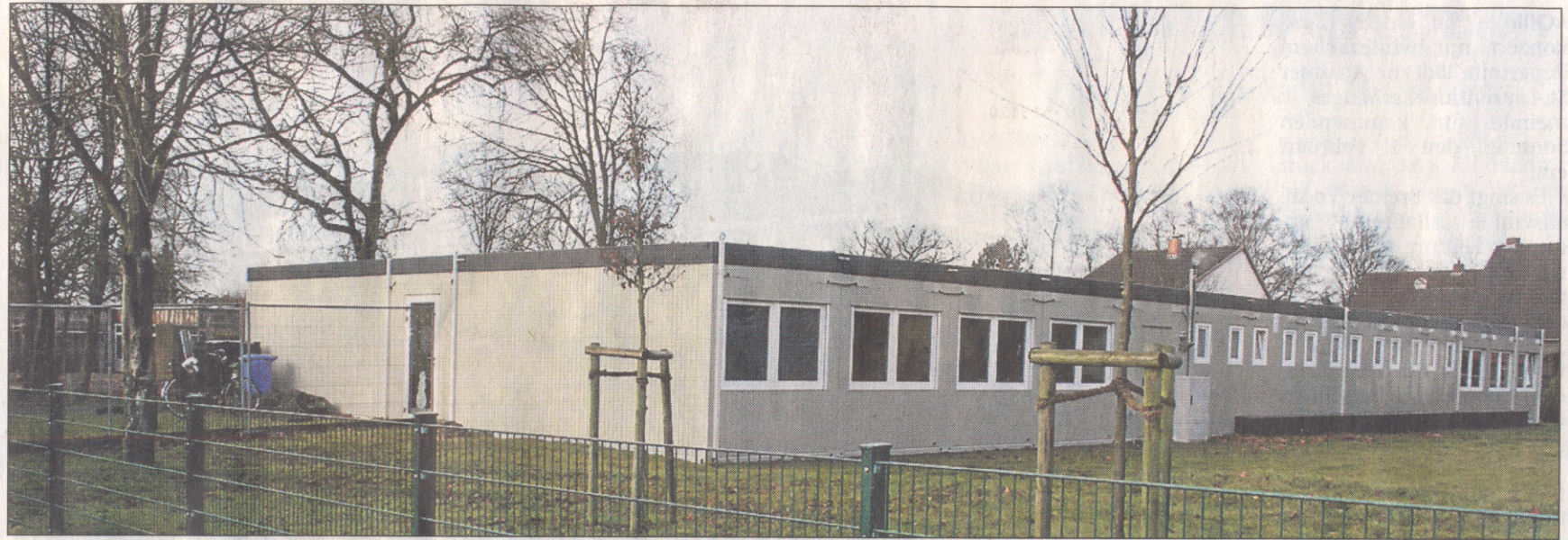
Das Kindergartengelände an der Heinrich-Laakmann-Straße war schon fast verkauft an ein Wohnungsbauunternehmen. Erst dann merkte die Stadt, dass sie den Kindergarten in vergrößerter Form weiter benötigt und sanieren muss. Derzeit läuft der Kindergartenbetrieb in diesen großen Containern. ■ Foto: Brodt
